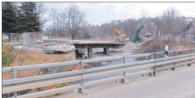
Zuerst wurde die alte Fahrbahndecke entfernt, danach die Leerverrohrung der Medien und die Abdichtungen. Als letzte Arbeiten werden die Widerlager auf beiden Seiten abgerissen. Das Abrissgut wird sortiert und auf die Deponie gebracht.
