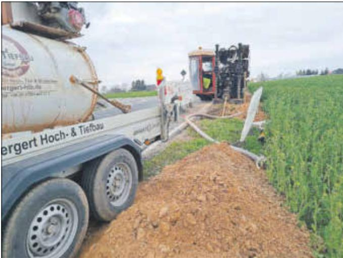
Grabenlose Verlegung im Spülbohrverfahren am Jägerhorn
