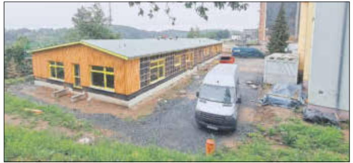
Seit Mitte Juni sind die Arbeiten am Dach und Baukörper soweit fortgeschritten, dass die Außenhülle geschlossen ist und die Innenausbaugewerke Elektro-, Sanitär- und Lüftungsinstallation sowie Trockenbau ihre Tätigkeit aufnehmen. Trotz knapper Kapazitäten sind für alle Gewerke Anbieter gefunden worden.
